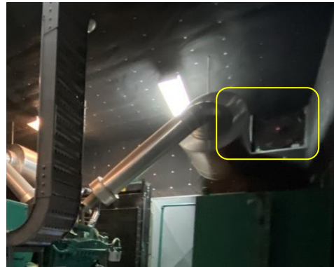
รูปที่ 31 ตะแกรงกันเสียงพัดลมระบายอากาศ
