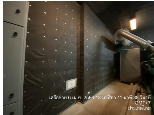
รูปที่ 11 บุผนังทุกด้านและเพดานห้องเครื่องกำเนิดไฟฟ้า
