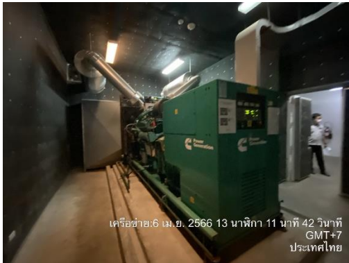
รูปที่ 11 บุผนังทุกด้านและเพดานห้องเครื่องกำเนิดไฟฟ้า
