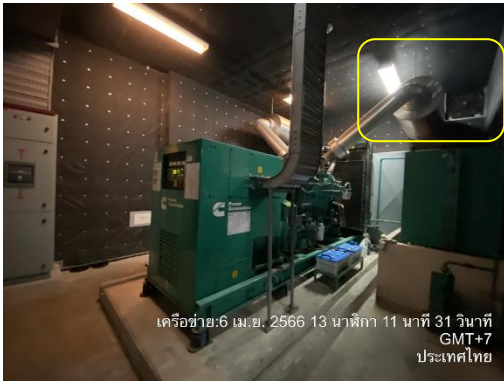
รูปที่ 30 ช่องระบายอากาศห้องเครื่องกำเนิดไฟฟ้า
